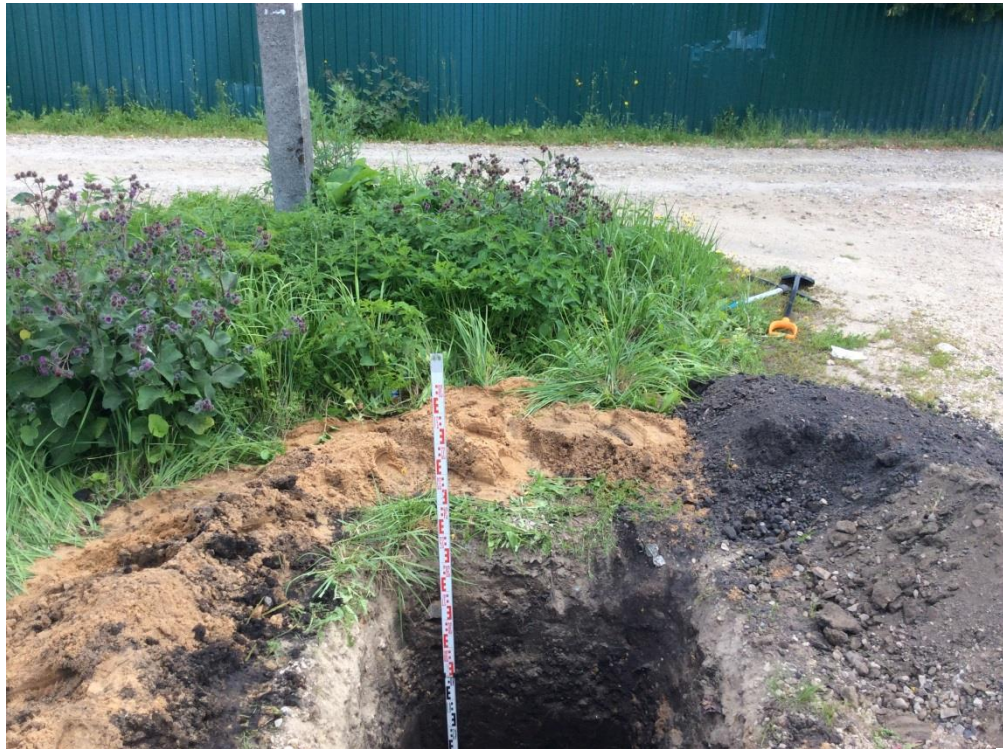
Рис. 15. Участок проведения археологических исследований на объекте: «Газификация Боровской городской бани по адресу: г. Боровск, ул. Женщин Работниц, д. 5». Шурф. Вид с запада.
